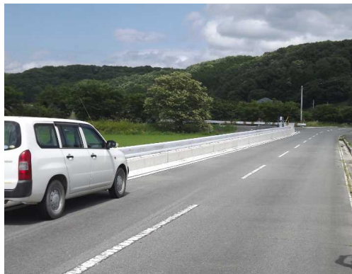
ガードレール基礎のような二線堤
