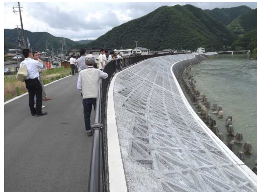
巻堤により補強された堤防
