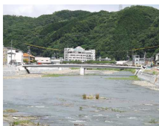
←新くなった佐用大橋 (完成2014.4)
