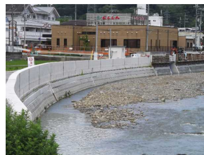
改修された佐用中心市街地の護岸
