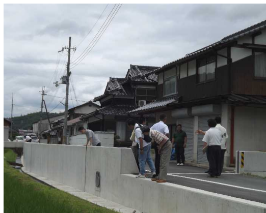
腰高ほどの輪中堤
