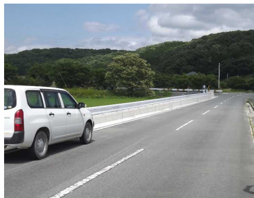
ガードレール基礎のような二線堤
