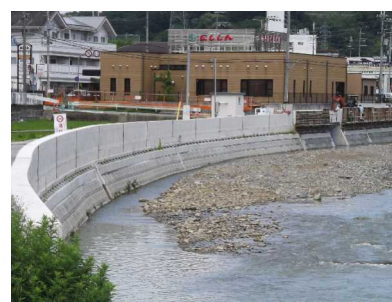
改修された佐用中心市街地の護岸
