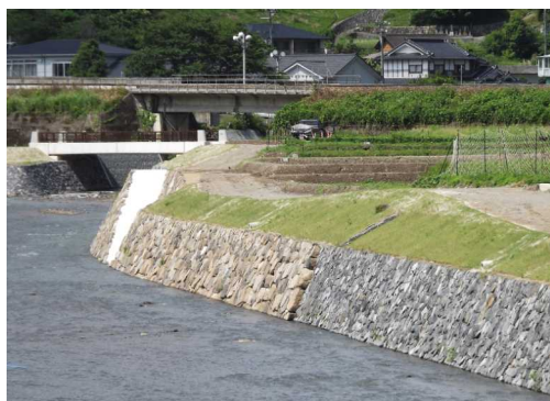
石積護岸(左側が発掘された石垣の再利用)
