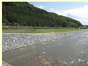
▲改修後の護岸
