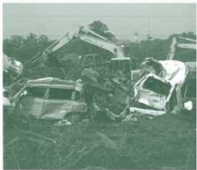
【伊豆大島工砂災害で復旧作業を行う建設労働者】
