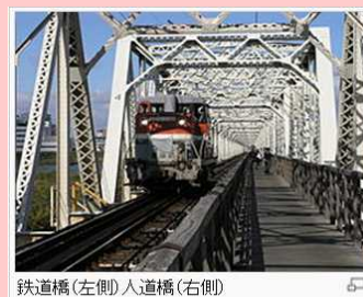
鉄道橋(左側)人道橋(右側)
