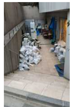
被災した地下クリニック
