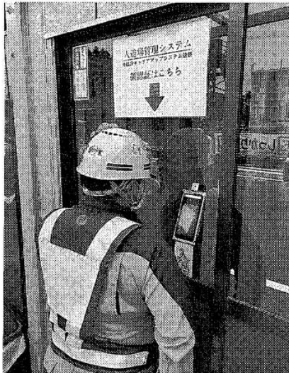
カードリーダー以外で履歴登録可能な仕組みも順次拡充している(写真は顔認証による入退場管理システムの活用例)
